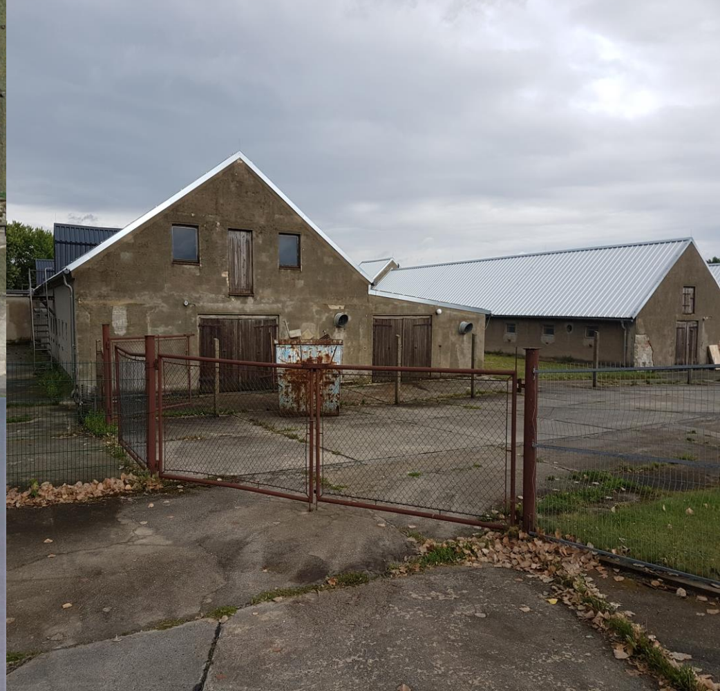
Drei stillgelegte Schweineställe in Nebelschütz, Landkreis Bautzen
