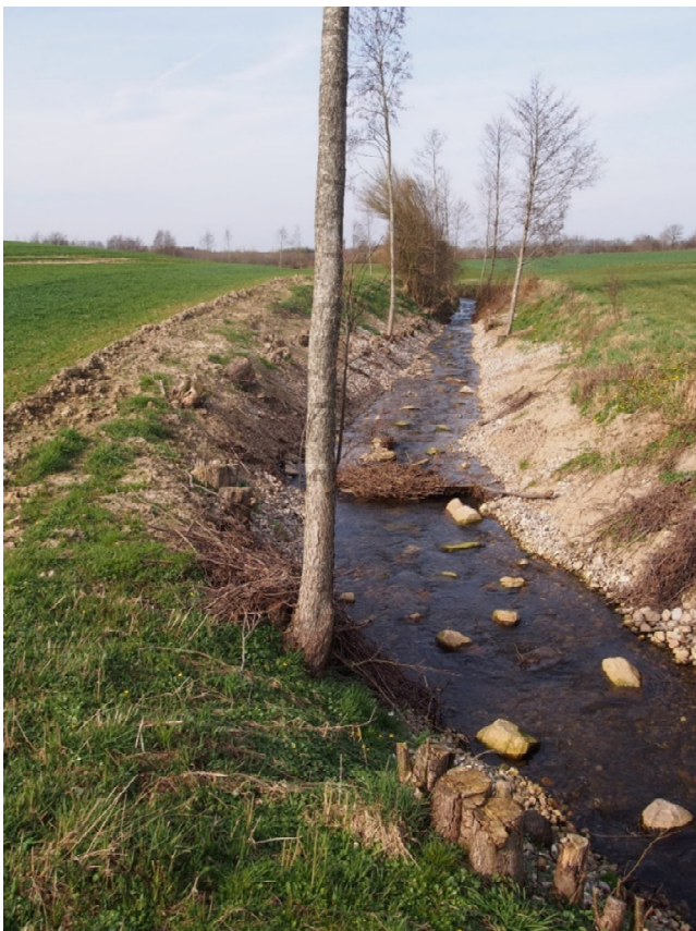
Abbildung 4: flächiger Einbau inklusive Lesesteine (Strömungsenker) und Totholz
