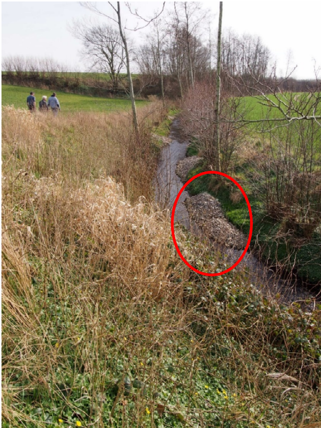
Abbildung 3: punktueller Einbau (Depot) im Uferbereich
