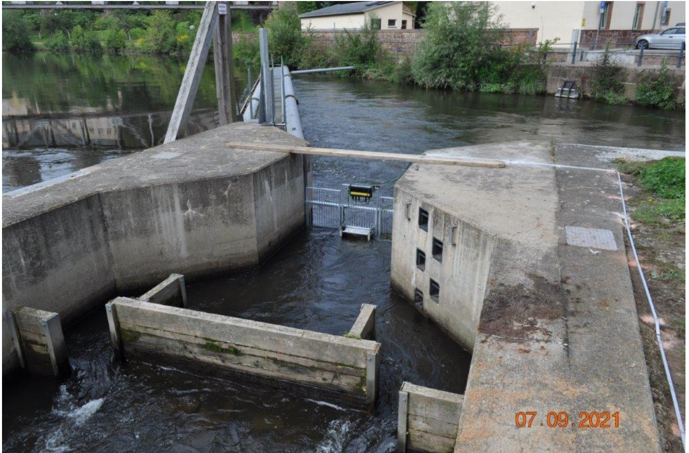
Abbildung 5: Vaki-Counter in der Fischaufstiegsanlage der WKA Schlossmühle Rochlitz - Zwickauer Mulde
